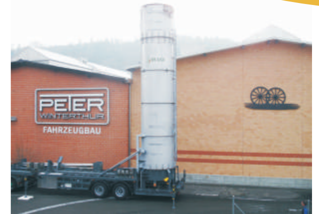
Aufgerichteter Kamin mit ausgefahrenen Zylindern
