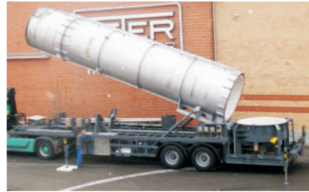
Aufrichten des Kamins – durch zwei seitliche Zylinder werden die Abstützträger ausgefahren
